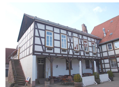
Gasthaus-Saal / ehem. mit Stallungen
