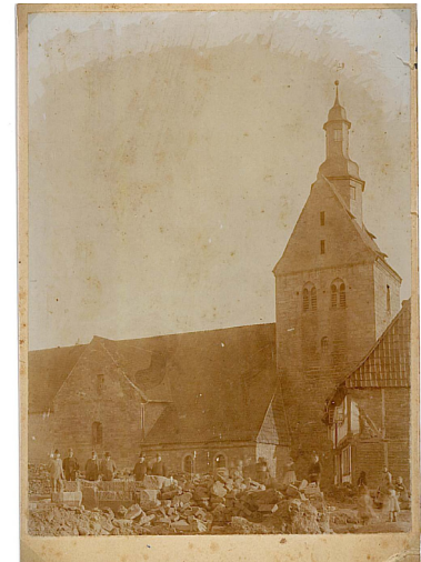
Aufnahme des Vorgängerbaus
